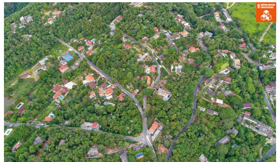
Imagem aérea do bairro Sítio do Morro que está com as ruas 100% asfaltadas
